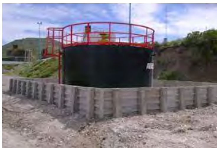
Figura 45: Almacenamiento de hidrocarburos
