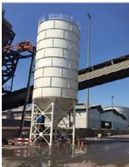
Figura 47: Silo de cemento de 385 m 3 de capacidad
