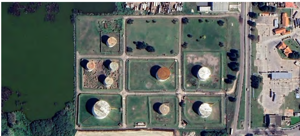
Figura 17: Parque de tanques de combustibles
